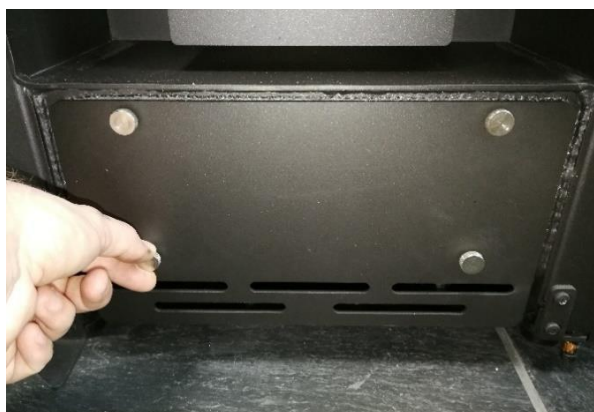
Bild 1: Skruva loss de fyra skruvarna och ta bort plattan för att lokalisera rökstyrningsplattan.
